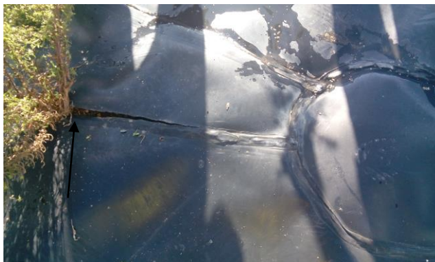
Figure 9a. Fissuration de bordure d'extrusion
